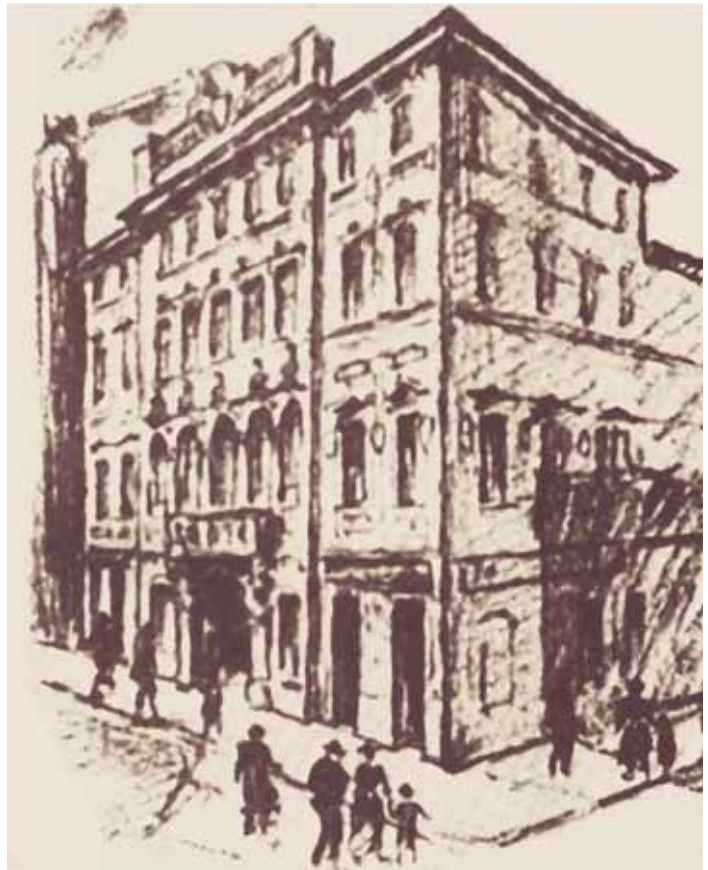
A Franklin Társulat épülete
