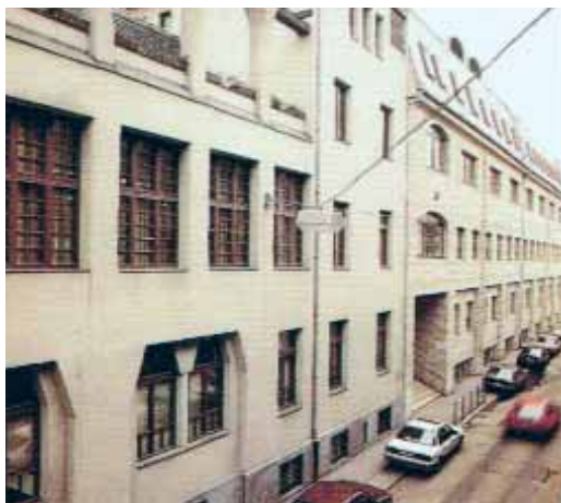
A szakközépiskola épületegyüttese
