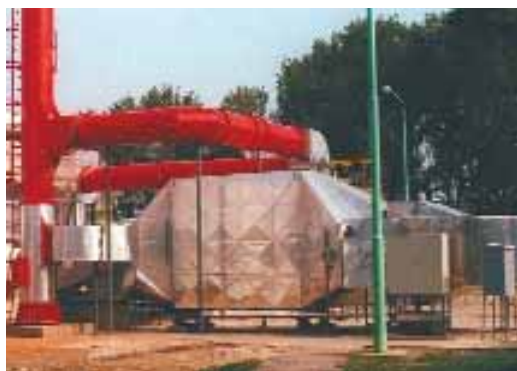
5. ábra. Flexónyomda katalitikus utóégetője
