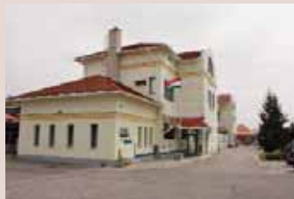
Az OOK nyomda épülete
